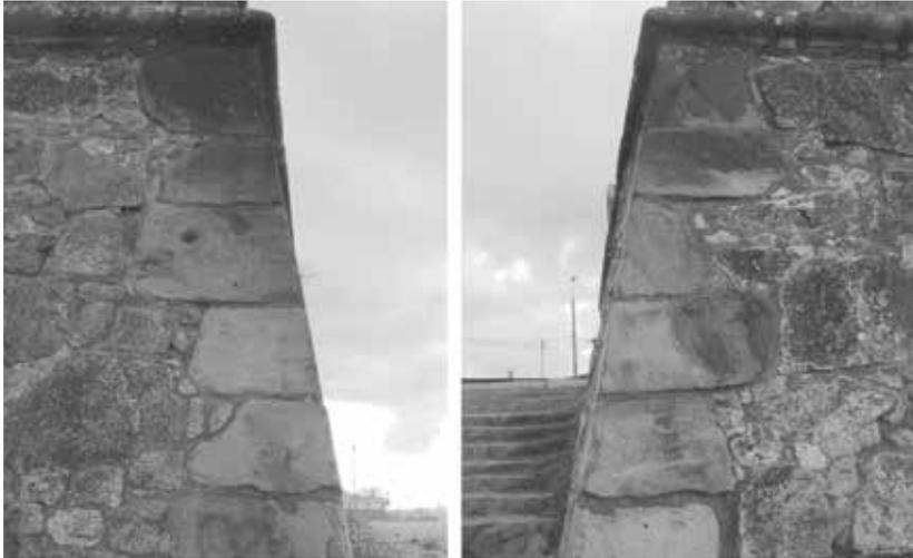
Figura 13. Sillares de un vértice, labrados por más de una cara, puestos a soga y tizón; la figura permite advertir el uso de esta técnica. También se observa que están labradas por sus caras ortogonales.
